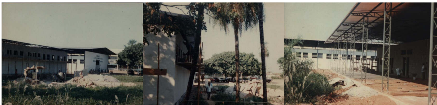
Fotos 01, 02 e 03 - Construção da sede da Escola de Aplicação Fonte: DCE Livre “Paulo Freire”
